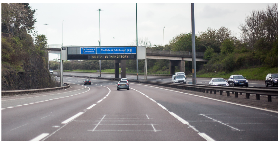
Figura 2.3: Exemplo de sistema de detecção de loop indutivo (marcas no asfalto) (METROCOUNT, 2020).
