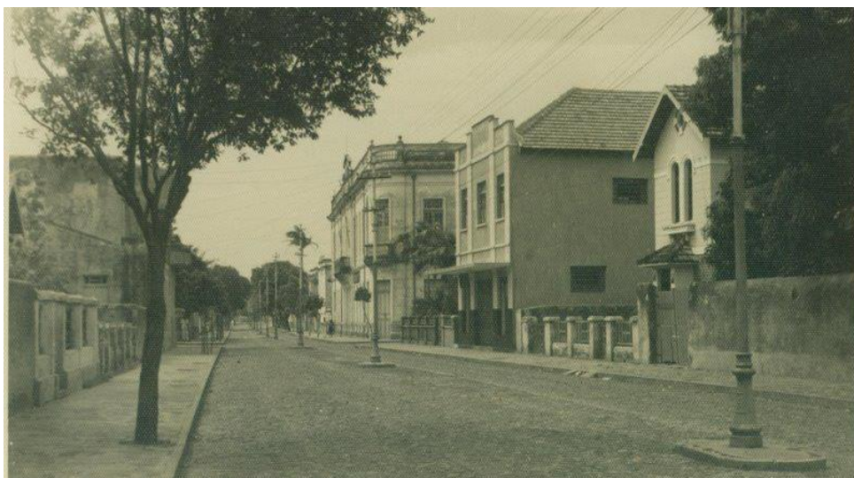
Figura 8 – Vista da Rua Grande em meados dos anos 1930.
