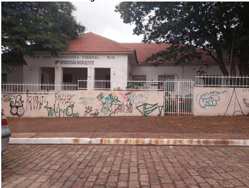
Rua General Mello, n.º 23, Orla Ferroviária - 20/12/2023, 10h30
