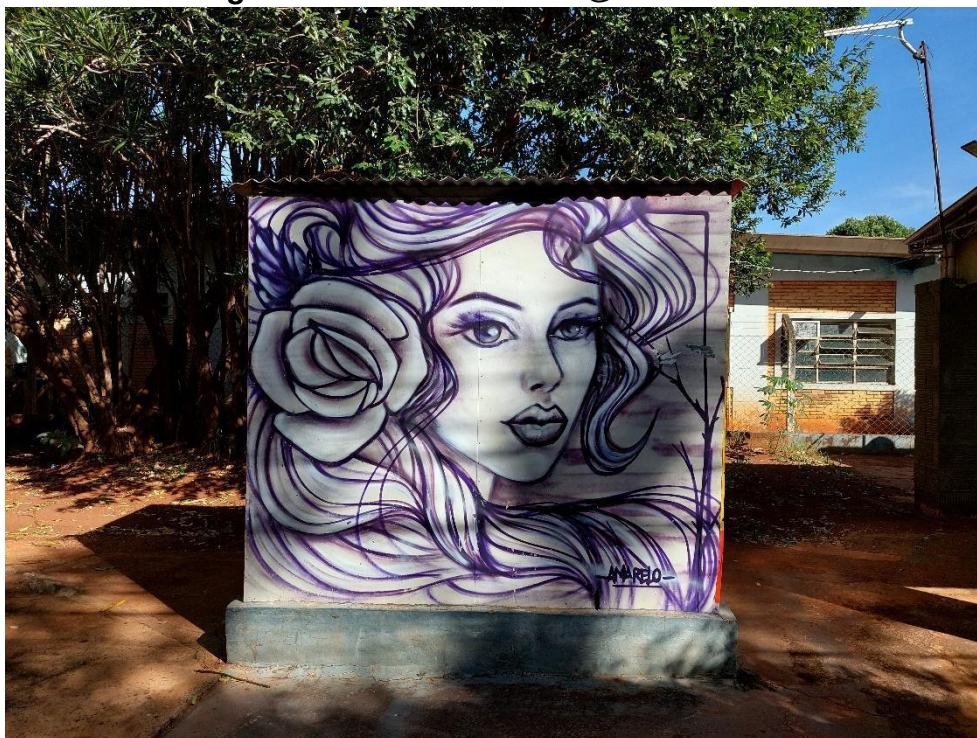
Avenida dos Crisântemos, Bairro Lar do Trabalhador – painel de entrada de energia elétrica na lateral da UBS – 14/07/2022, 9h25
