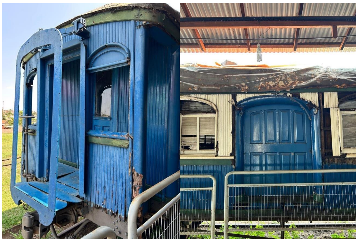
Figura 16 – Vagão histórico de passageiros na Esplanada Ferroviária de Campo Grande (MS). Fotografado em diferentes ângulos, evidencia o estado de deterioração da estrutura. Apesar de reconhecido como parte do patrimônio ferroviário, sua restauração não é possível devido à ausência de documentação regularizada, mantendo-o num limbo burocrático entre memória e abandono. Fonte: autoria própria.
