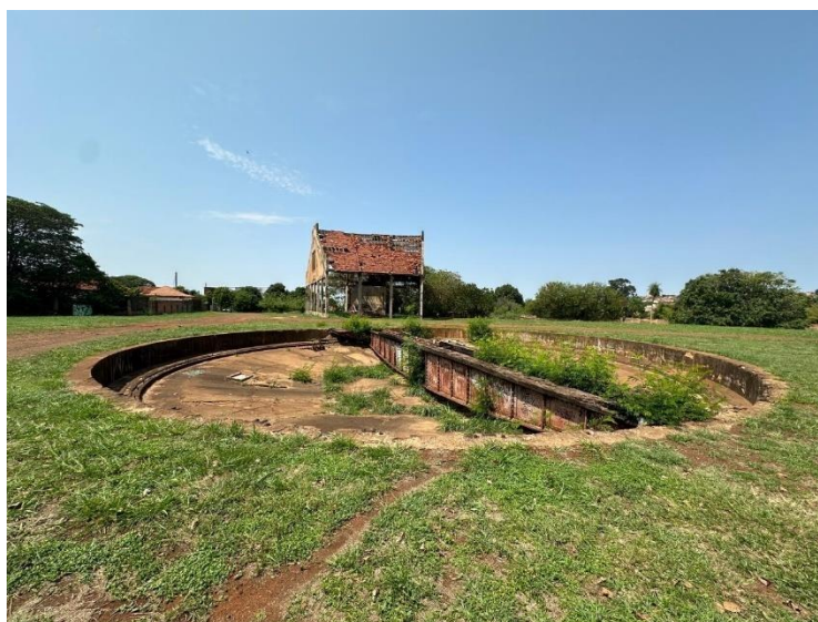
Figura 17 – A Rotunda da antiga estação ferroviária de Campo Grande.
