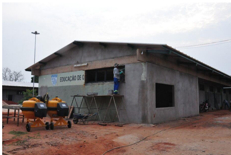
FIGURA 2 – REFORMA DA ESCOLA ESTADUAL CÂNDIDO MARIANO
