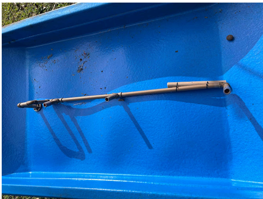
Figura 13. Três pontos de drenagem conectados ao sifão em “U” invertido
