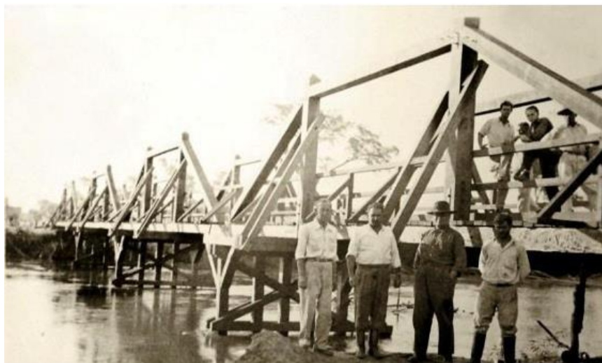
Figura 11: Primeira ponte sobre o Rio Dourados construída entre a CAND e a Vila Brasil
