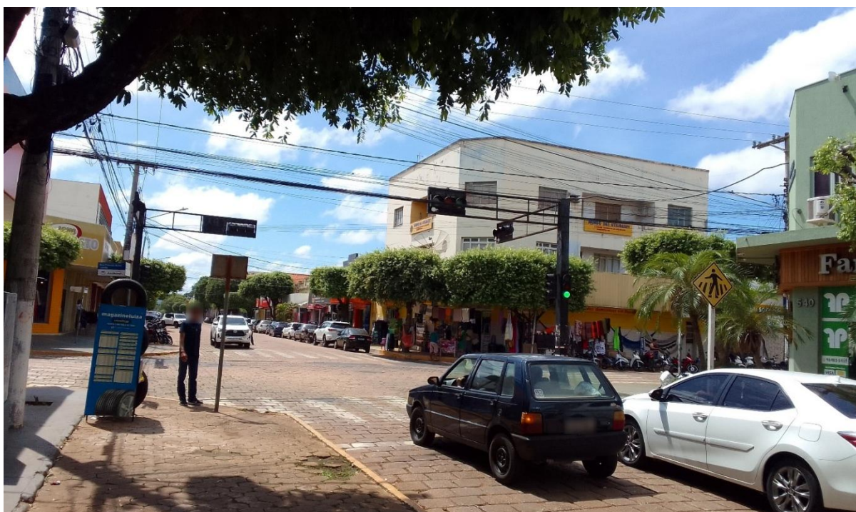
Figura 14. Semáforo em ponto central em Aquidauana/MS.
