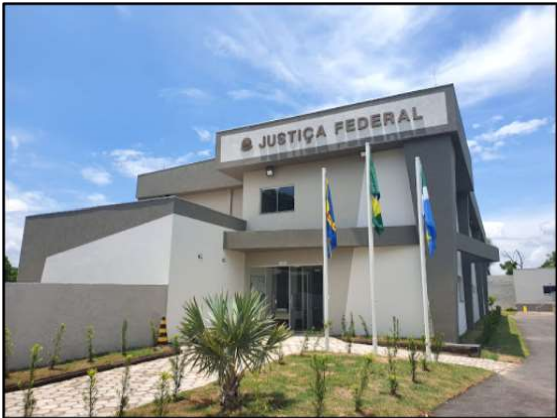
Figura 5 - Foto da sede da Justiça Federal em Corumbá
