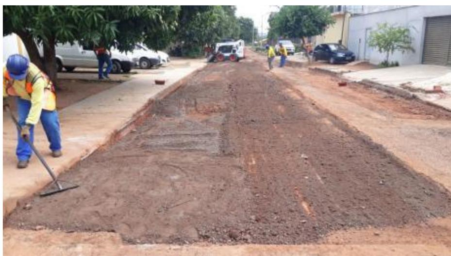
A execução de solo-cimento necessita de alguns cuidados e de cumprimento de algumas Normas específicas a serem seguidas, para que se tenha um material resistente e durável para o fim que se projeta. Porém, alguns cuidados estão relacionados estreitamente as características do solo (granulometria e a uniformidade) que está trabalhando, onde poderá haver interferência na quantidade de cimento e de água a serem aplicadas no material. [35]
