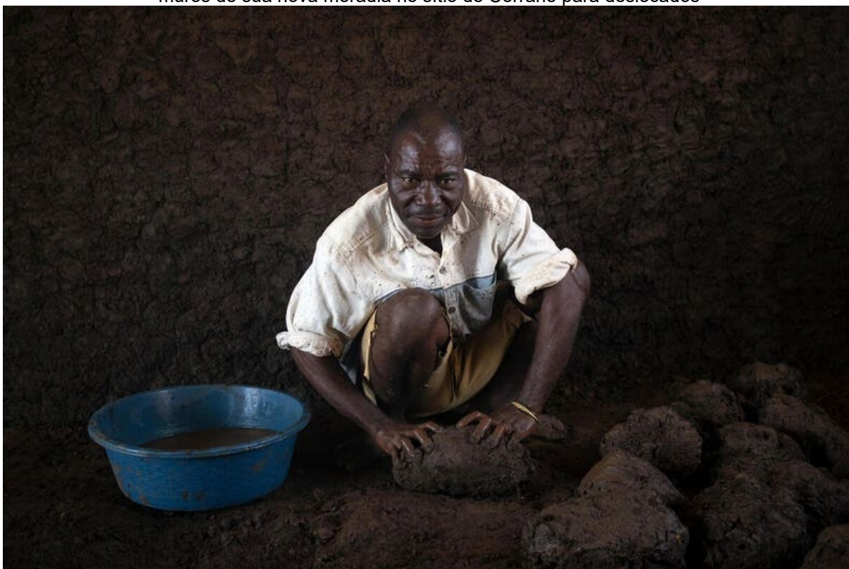
Figura 13 – Patrício Alberto Mponda prepara uma mistura de água com barro para a construção de muros de sua nova moradia no sítio de Corrane para deslocados
