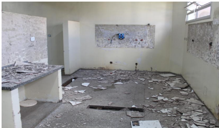
Figura 9 - Reforma do Restaurante Universitário da UFGD
