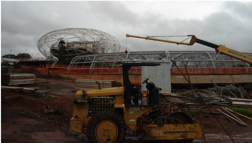
Figura 14 - Bioparque Pantanal no início das obras em 2014
