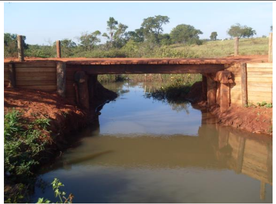
Ponto 2 - Ponte sobre o córrego
