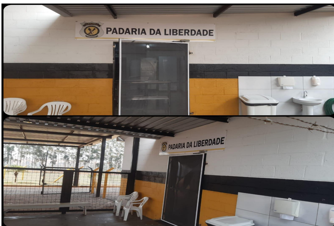
Figura 12 – Fachada da entrada da Padaria da Liberdade.
