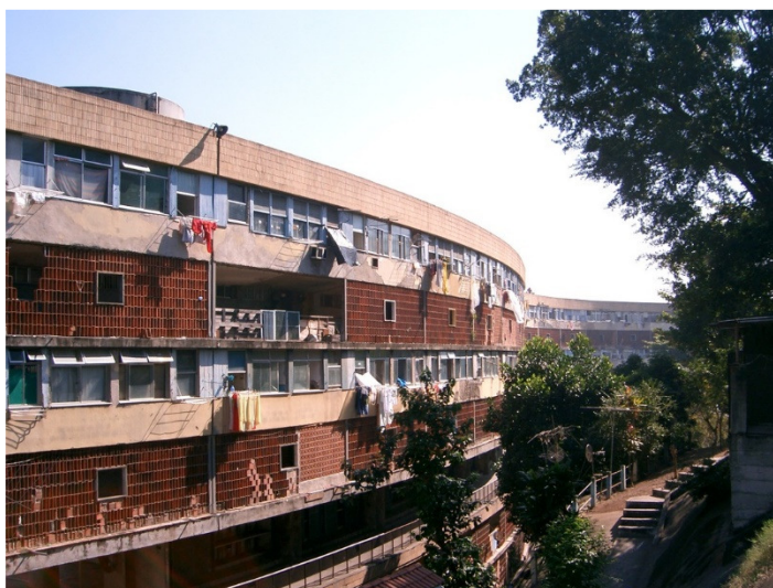
Figura 3. Vista do Conj. Habitacional Pedregulho, Rio de Janeiro.
