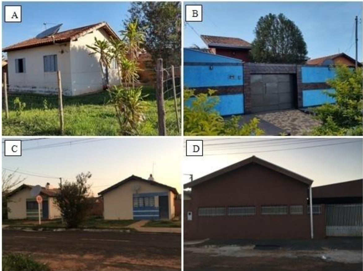
Figura 5: Alterações no padrão construtivo das residências nos conjuntos habitacionais estudados.
