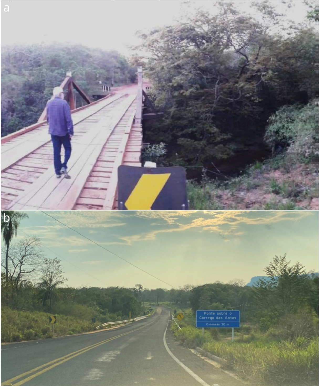
Figura 32 – Ponte sobre o Córrego das Antas (antes e após o asfaltamento).
