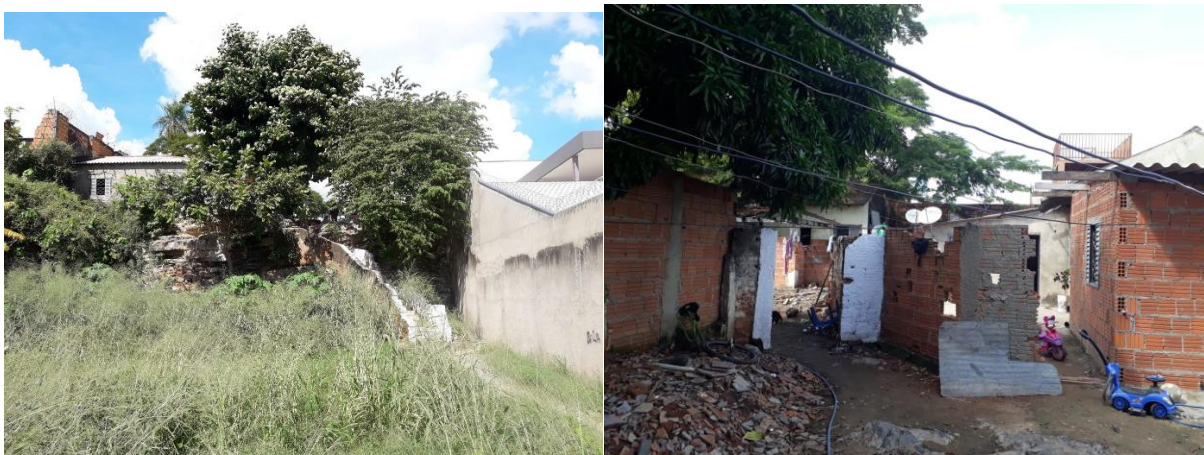
Figura 05 – Entrada do Território Campos Correa
