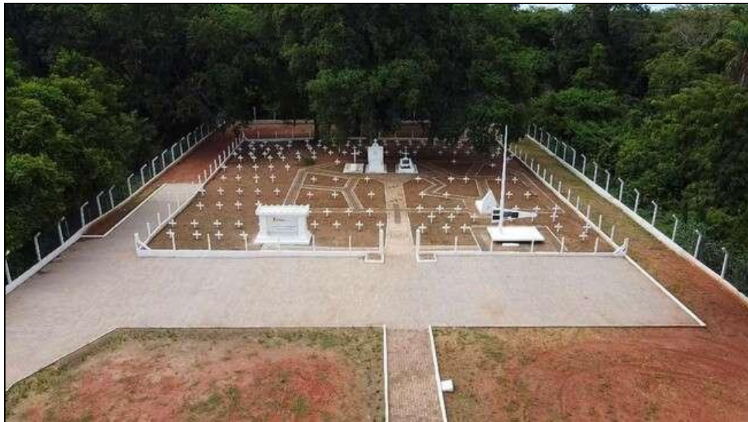
Figura 17 - Construção do pátio para formaturas.
