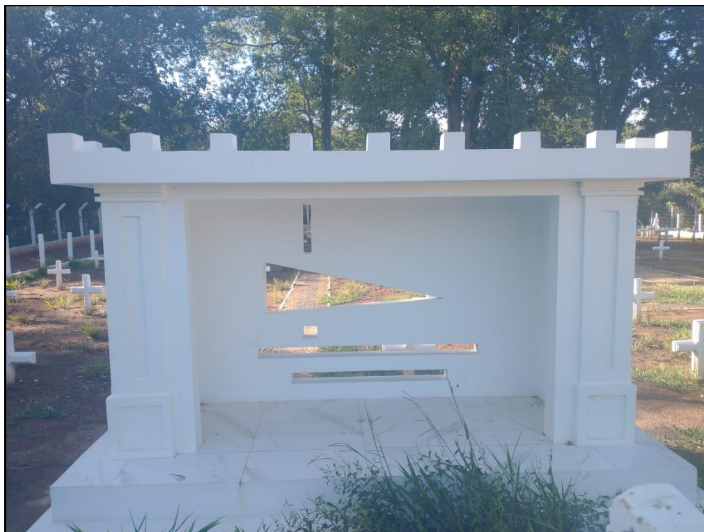
Figura 24 - Capela do cemitério dos heróis em Jardim-MS.
