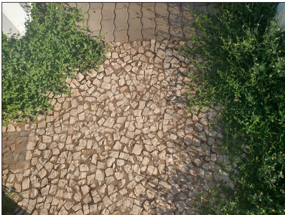
Figura 9 - Diferença da antiga calçada e as que foram construídas posteriormente
