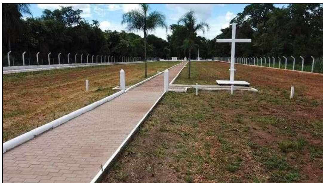
Figura 16 - Ampliação da calçada de acesso principal.
