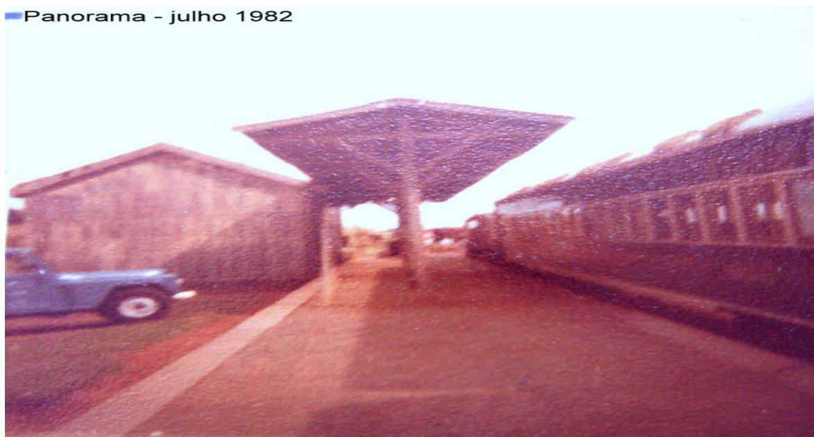
Figura 12: Antiga Estação Ferroviária de Panorama: Fonte: FEPASA, 1982
