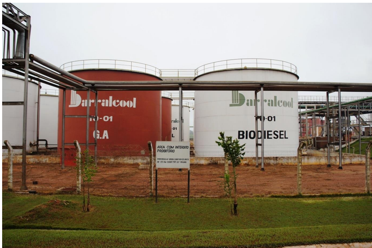
Figura 56: compartimentos para armazenamento de biodiesel produzido pela empresa Barralcool em Barra do Bugres/MT. Fonte: Tayrone Roger Antunes de Asevedo (2012).
