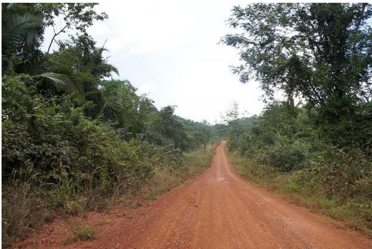
Figura 47: trecho de uma estrada que corta o assentamento Antônio Conselheiro - microrregião de Tangara da Serra/MT. Fonte: Tayrone Roger Antunes de Asevedo (2012).
