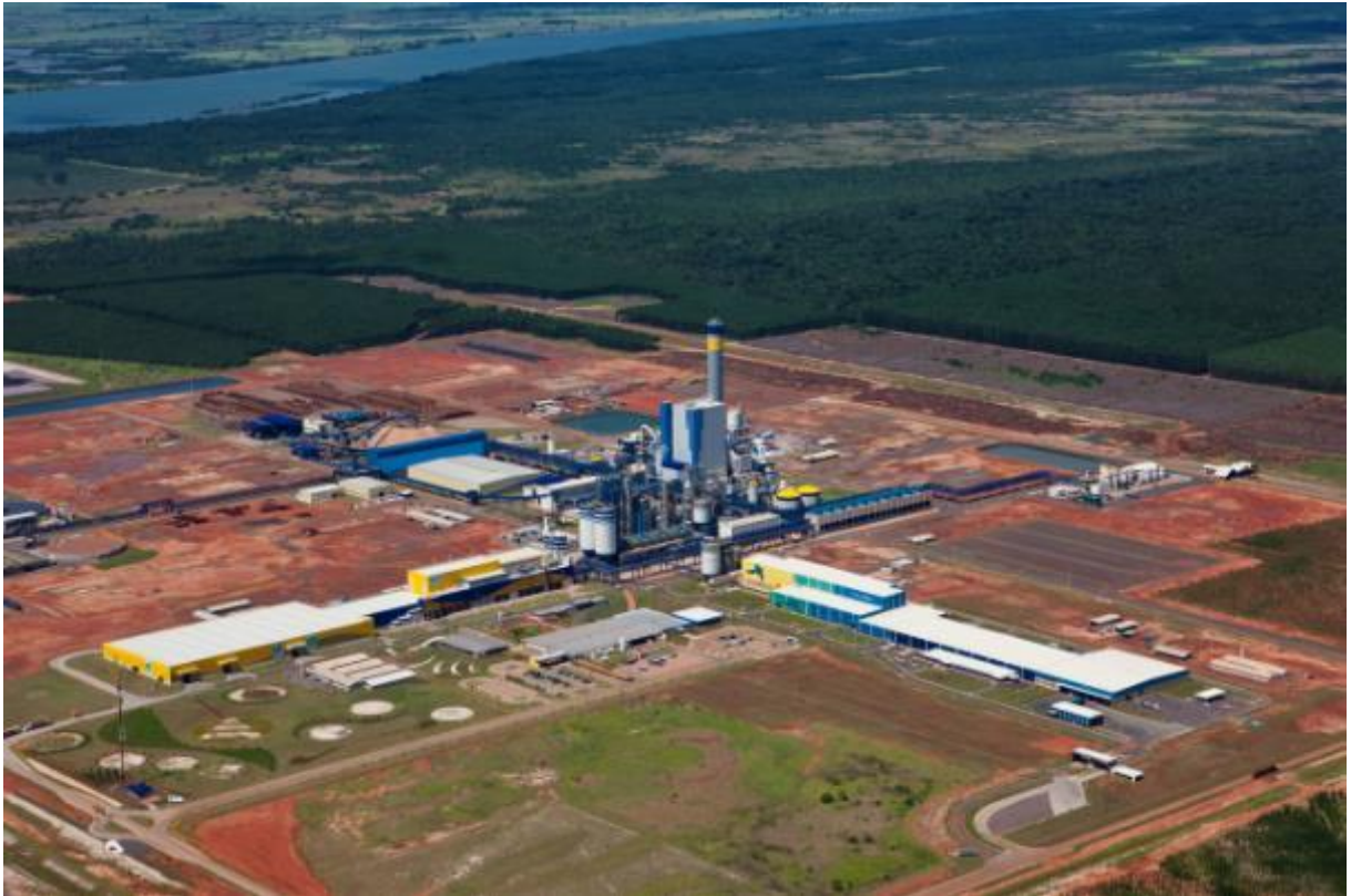
Figura 11: foto aérea da unidade industrial da Fibria de Três Lagoas tendo ao fundo o Rio Paraná. Fonte: Assessoria Fibria/Perfil News (2012).
