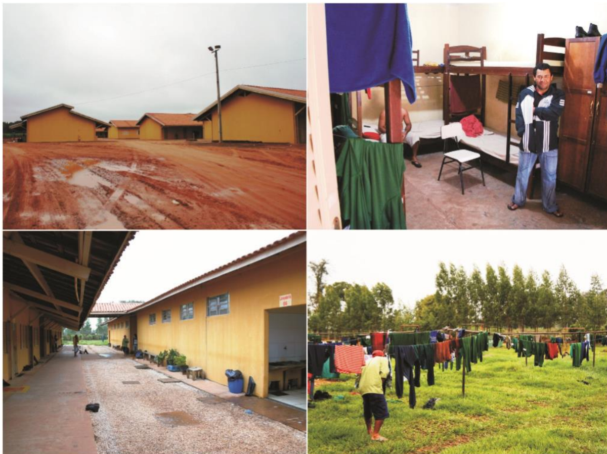
Figura 63: alojamento de trabalhadores da empresa Barralcool - município de Barra do Bugres/MT. Fonte: Tayrone Roger Antunes de Asevedo (2012).
