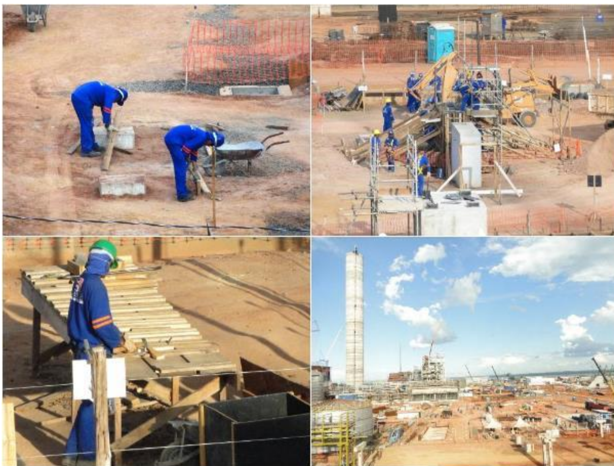
Figura 65: construção/montagem da planta fabril da Eldorado Brasil. Fonte: Tayrone Roger Antunes de Asevedo (2012).
