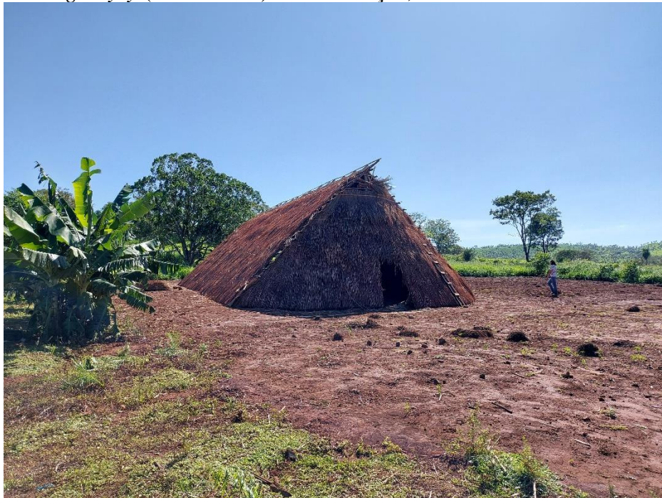
Figura 1 - Oga Pysy (casa de reza) em construção, no tekoha Ñande Ru Marangatu .
