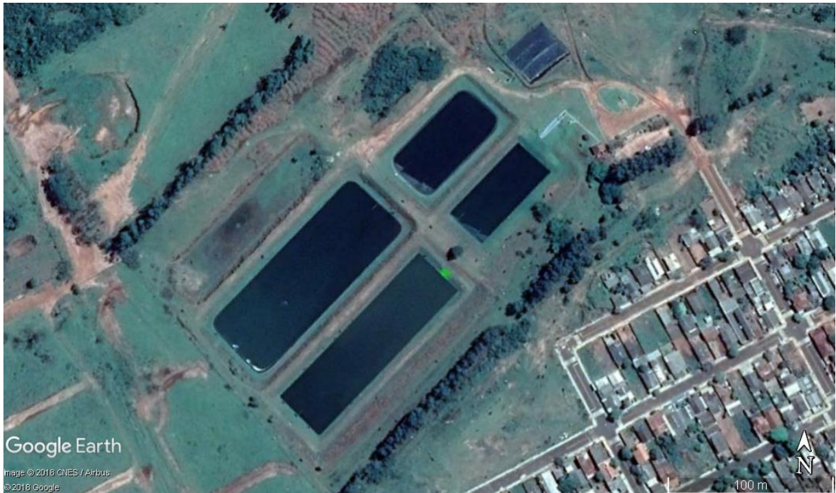
Imagem - ETE 1A Lagoa Anaeróbia + Lagoa Facultativa, vazão de projeto = 90 \text{ L}\cdot\text{s}^{-1} .
