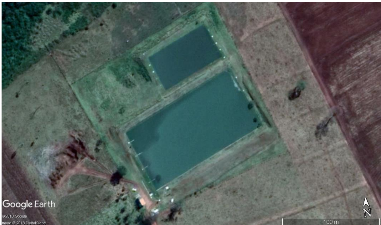
Imagem - ETE 2B Lagoa Facultativa + Lagoa de Maturação, vazão de projeto = 6 L.s -1 .
