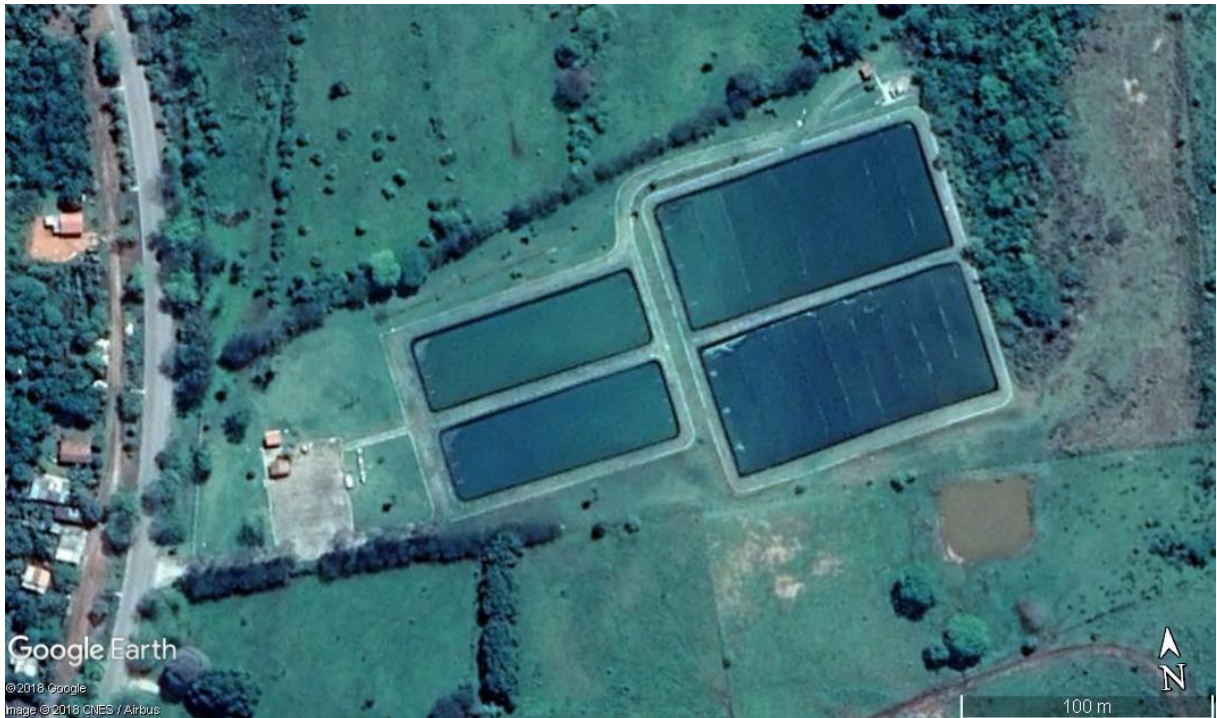
Imagem - ETE 2A Lagoa Facultativa + Lagoa de Maturação, vazão de projeto = 20 L.s -1 .
