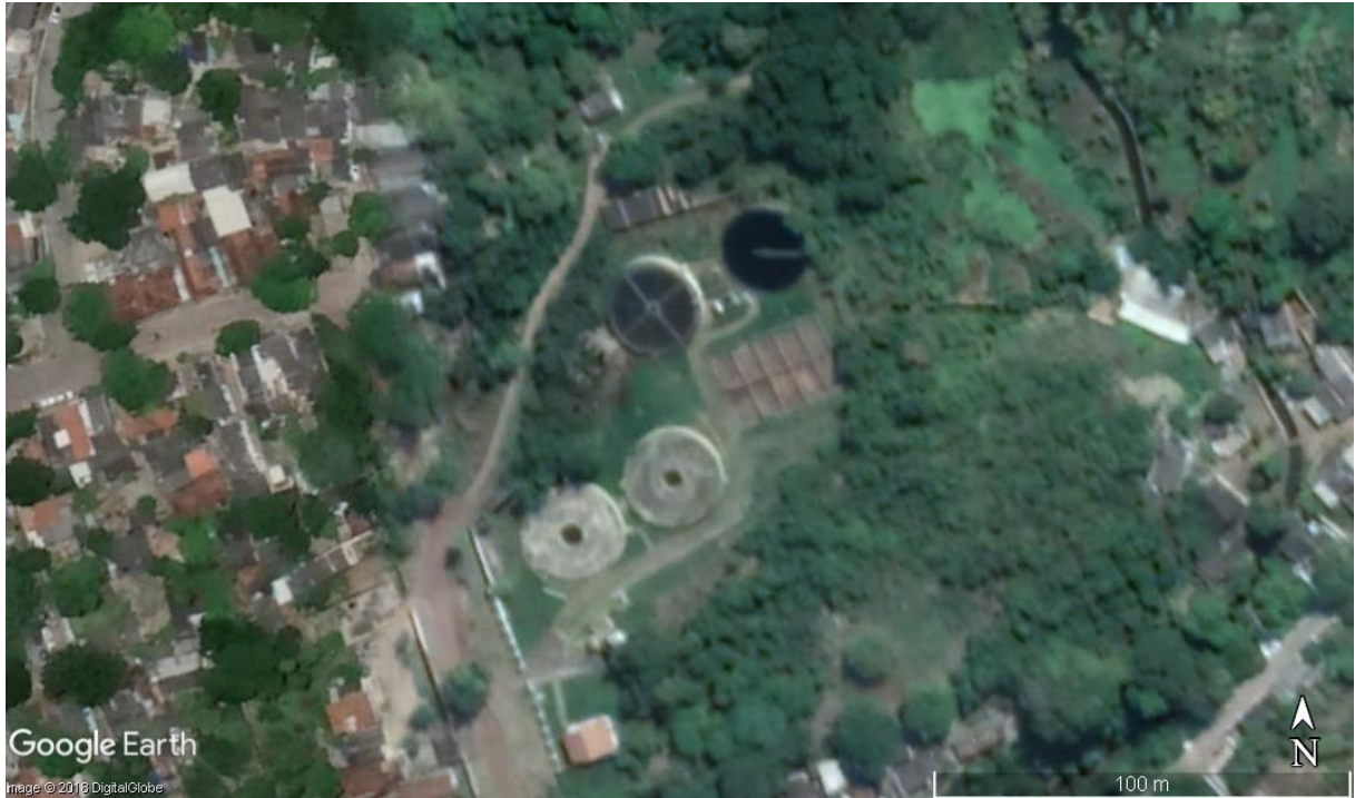
Imagem - ETE 5A Reator UASB + FBP +DS, Vazão de projeto = 80 \text{ L}\cdot\text{s}^{-1} .
