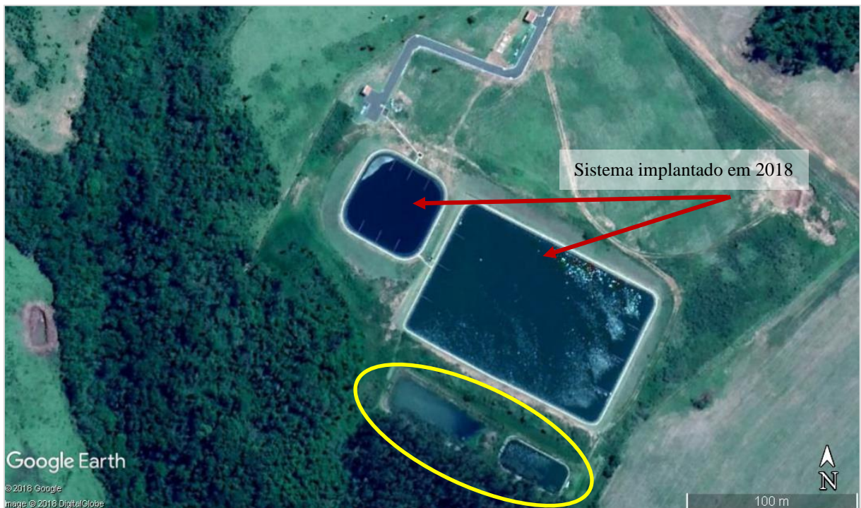
Imagem - ETE 1B- Lagoa Anaeróbia + Lagoa Facultativa, vazão de projeto = 5 \text{ L}\cdot\text{s}^{-1} .
