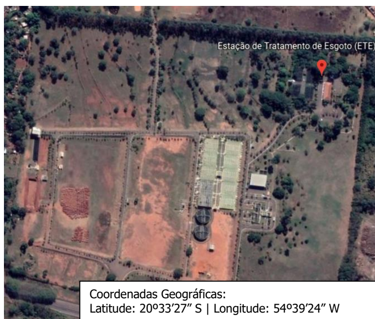
Figura 4 - Localização da ETE onde o efluente secundário foi coletado
