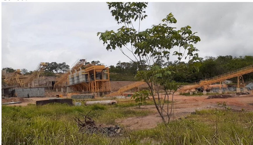
Figura 78 – Novas instalações da mineradora Horii na estrada que dá acesso ao Assentamento Canaã.
