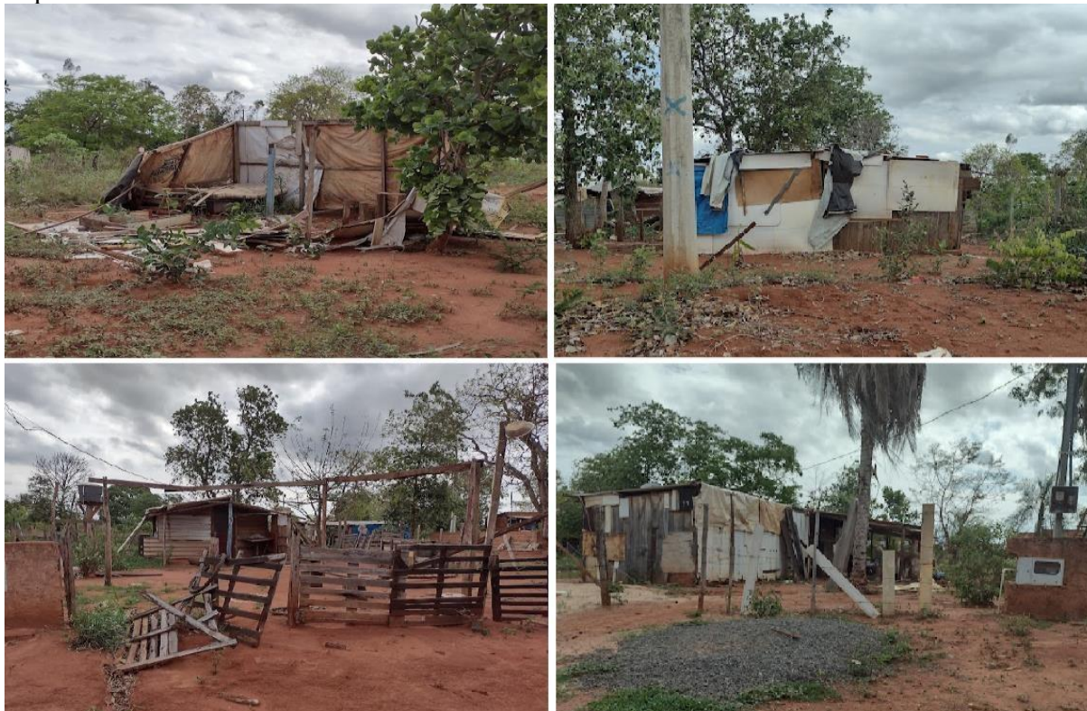
Figura 6 - Barracos abandonados observados na ocupação urbana Jardim São Francisco II, Aquidauana – MS.
